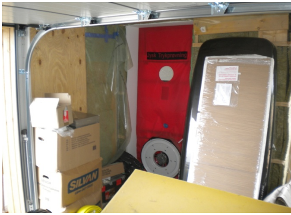
Blowerdoor set ude fra
