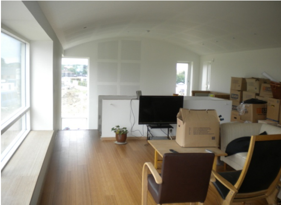
Status på klimaskærm
