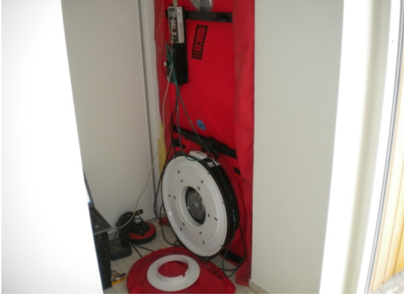
Blowerdoor set inde fra
